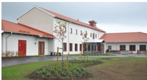
Äldreboende och Trygghetspunkt i Katthammarsvik
