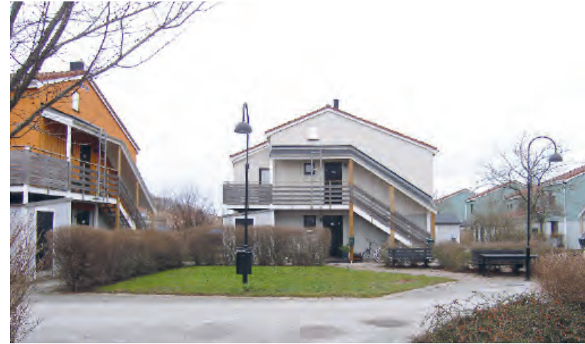
I Yttre Furulund, som på bilden vid Trädgårdsgatan, finns tidstypisk bebyggelse med välorganiserade yttre miljöer med bilfria transportytter.
