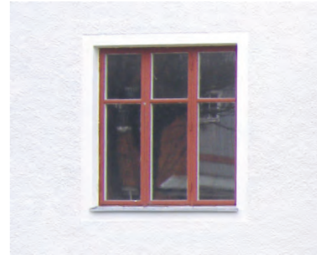
Fönstren har en högst rektangulär form och en indelning av lufterna som funnits sedan 1870-talet.
