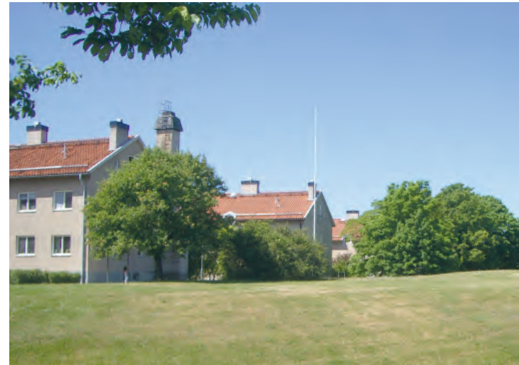
Den vanligaste höjden på lamellhusen i Visby under den aktuella perioden är två till tre våningar. Huskropparna är ofta parallellt utlagda med öppna gårdsrum emellan, men det finns även de som är lagda i vinkel så att mer eller mindre tydligt slutna gårdsrum bildas. Kvarteret Acacian.
