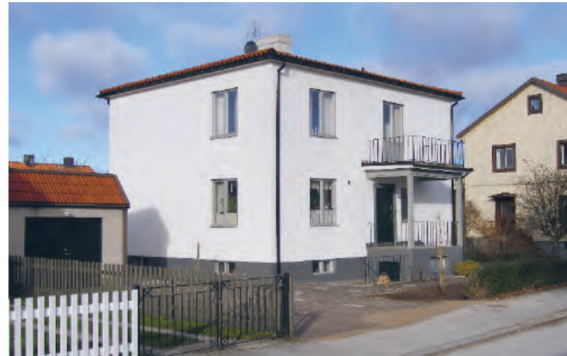
Funkisvilla vid Vinetagatan uppförd 1936. Byggnaden har bevarat grunduttrycken väl men har getts en väl hårt markerade sockelfärg. Lägg märke till öppenheten i tomtragränsen vilket ingick i stilkonceptet.
