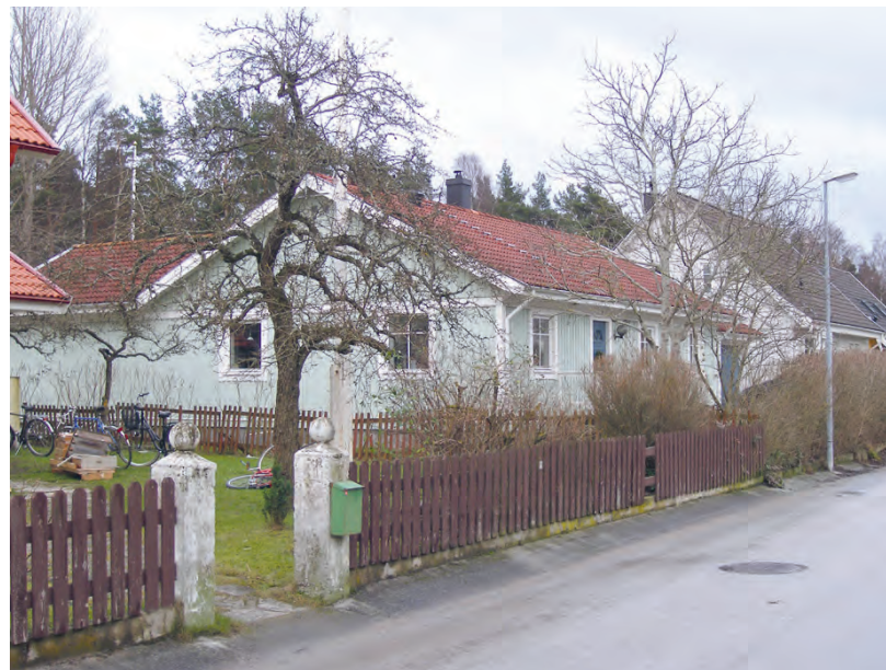
Villa i kvarteret Fältspaten i Djuplunda uppförd 1987. Detta och det bakomliggande huset är tidstypiska trähusvillor i 1 och 1½-plan utan källare.
