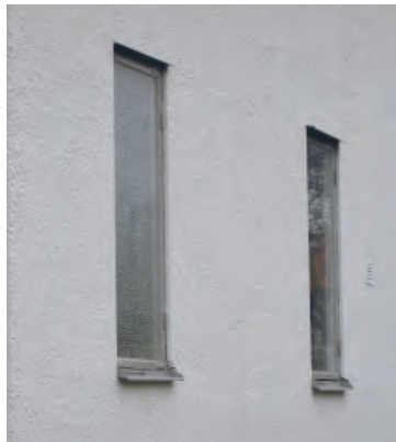
Fönstren ligger i liv med fasaden. Raka linjer, tunna ytor och skarpa vinklar.
