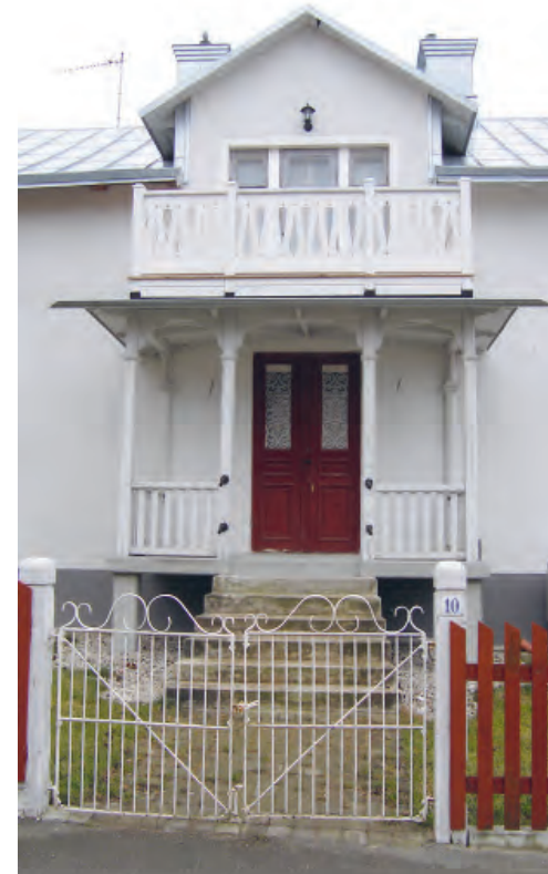
Dalian 12 - Tidstypisk byggnad som nyligen renoverats.
