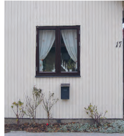
De utåtgående fönstren är symmetriskt placerade, har stående proportioner och två fönsterlufier.
