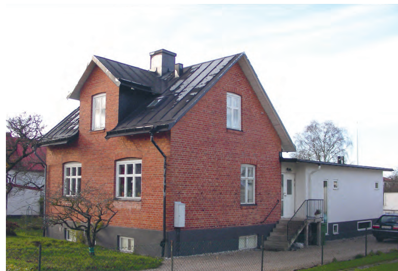
Det här huset byggdes på Östra Vi i början på 1910-talet, en tid då området stod för en stor del av stadens byggnadstillskott. Tillbyggnaden gjordes i början på 2000-talet med en helt modernt utformad låg huskropp dockad mot det gamla trapphuset på gårdssidan. Detta sätt att utvidga bostadsytan innebär att den gamla byggnaden bibehåller sin dominans och att den för bebyggelsestrukturen i kvarteret viktiga gårdsstrukturen bevaras på ett smakfullt sätt.
