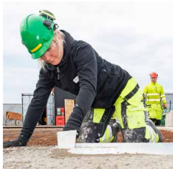
Elever på bygg- och anläggningsprogrammet utför markberedning vid räddningstjänstens nya övningsanläggning
