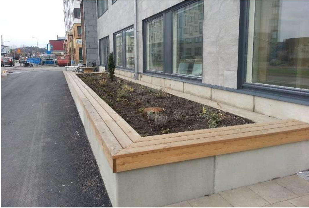
Figur 12. Avledning av dagvatten från tak via stuprör till upphöjd växtbädd (Foto: Norconsult).
