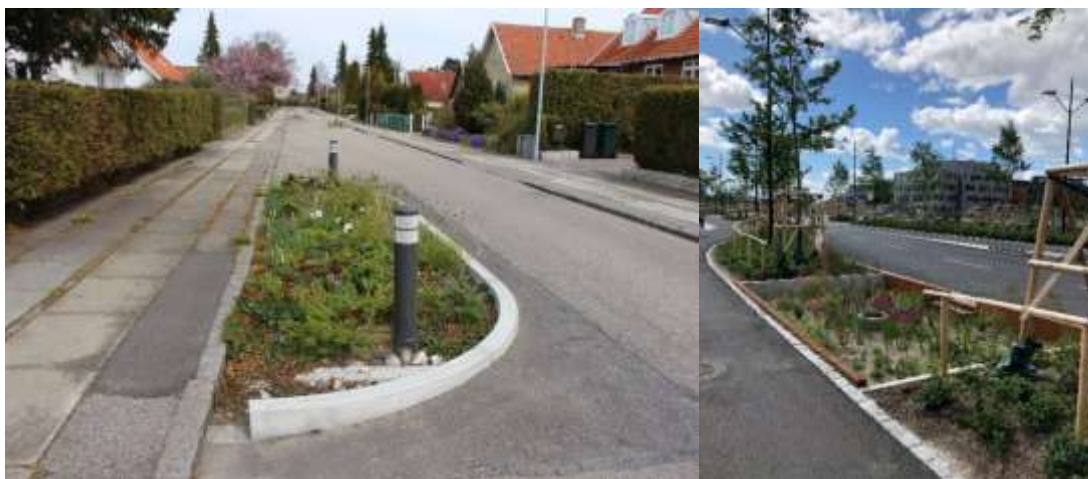
Figur 11. Nedsänkta växtbäddar vid vägytor (Foto: Norconsult).
