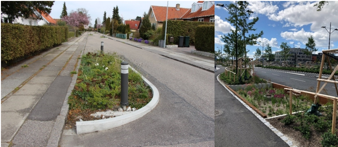
Figur 26. Nedsänkta växtbäddar vid vägytor (Foto: Norconsult).
