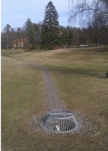
Figur 36. Foto av överdämningsyta (Foto: Norconsult).
