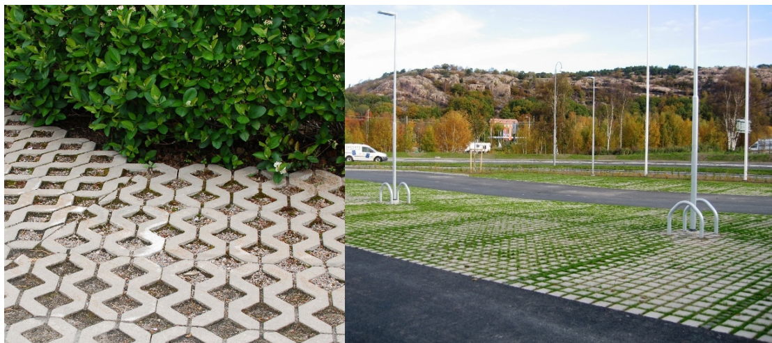
Figur 17. Två typer av genomsläpplig beläggning (vänster: Sweco (2018), höger: Norconsult (2019)).
