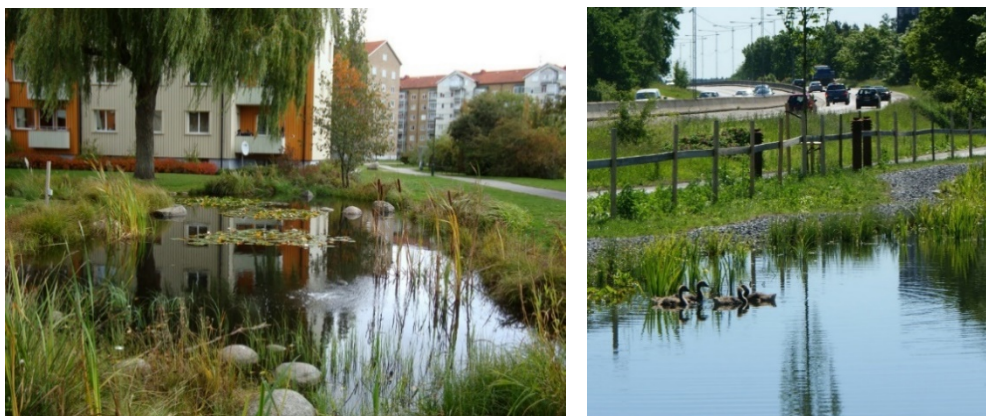
Figur 34. Bild av dagvattendamm (Sweco, 2018).
