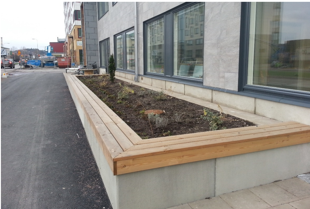
Figur 27. Avledning av dagvatten från tak via stuprör till upphöjd växtbädd (Foto: Norconsult).
