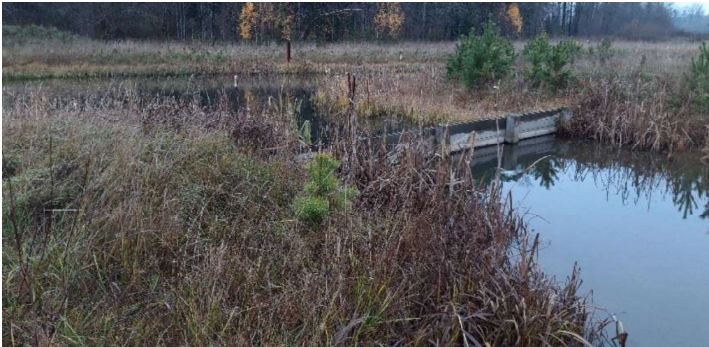
Fördamm(där inloppet mynnar) med olje/skräp- och slamavskiljande funktion
