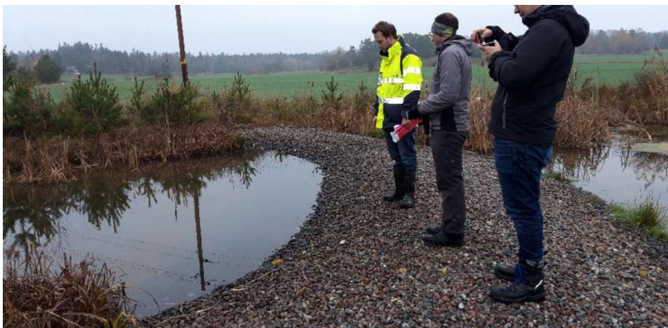
Grusfilter, efter fördamm, med tät lerkärna. Ger en nivåskillnad som är användbar bl.a. vid skötsel.
