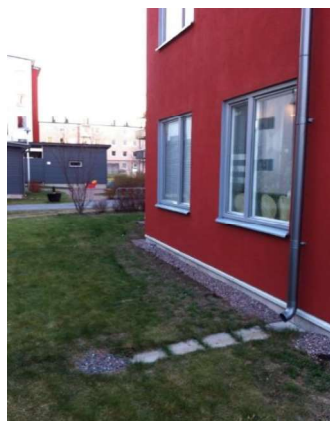
Figur 14 Avledning av dagvatten från hustak.
