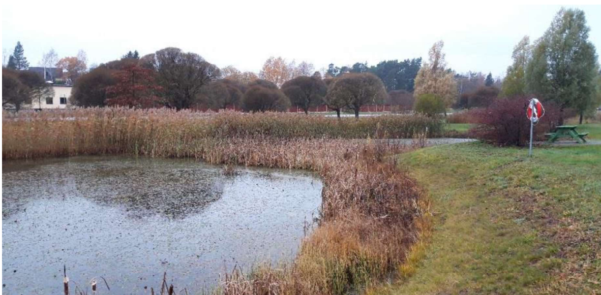
"Växtstaket" för att förhindra drunkningsolyckor samt ett grundare parti i dammen s.k. lågvattenströskel. I den bildar växterna ett filter som renar vattnet.
