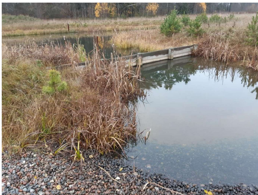
Foto: Lars Westerlund, bilden visar en "fördamm" till en dagvattendamm
