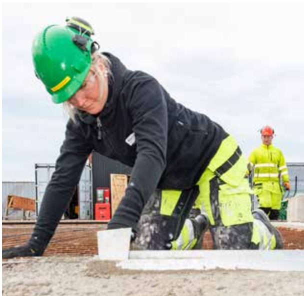
Elever på bygg- och anläggningsprogrammet gjuter en betongplatta vid räddningstjänstens nya övningsanläggning
